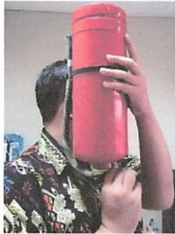
6. Yakinkan posisi Bracket dalam keadaan kuat dan melekat sempurna dgn dinding. (Berlaku untuk tabung model Portable Standard, baik Stored Pressure & Cartridge).
